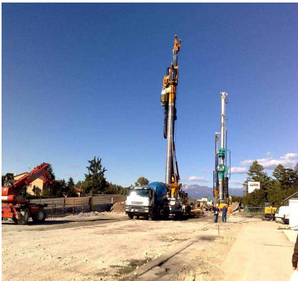
L'area di cantiere in oggetto con, sullo sfondo, le macchine per la realizzazione dei pali trivellati con camicia continua rotante
