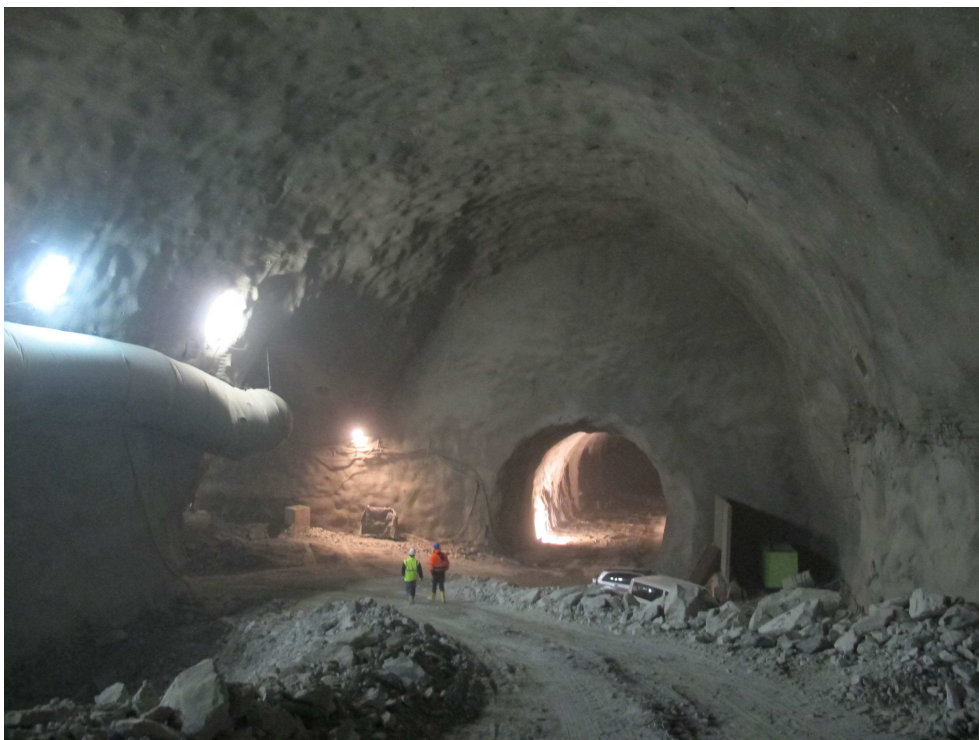
I lavori in corso nelle gallerie del Brennero.
