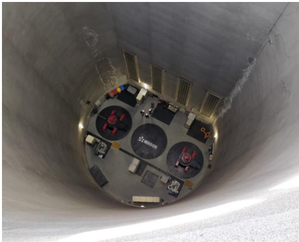
Figura 1: Pozzo per alloggiamento dei due gruppi generatori ad asse verticale, di cui la foto di dettaglio a destra.
